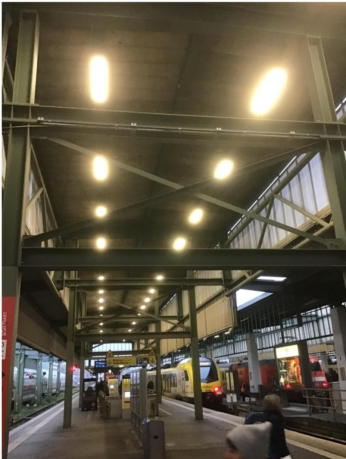
Bild 2: Nachträglich eingezogene Stützen für das Bahnsteigdach Gleise 3 - 4.
