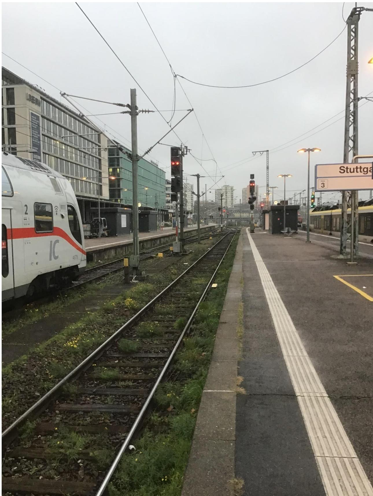
Bild 4: Einzelmasten für die Oberleitung Gleis 2 -3, kein Quertragwerk
