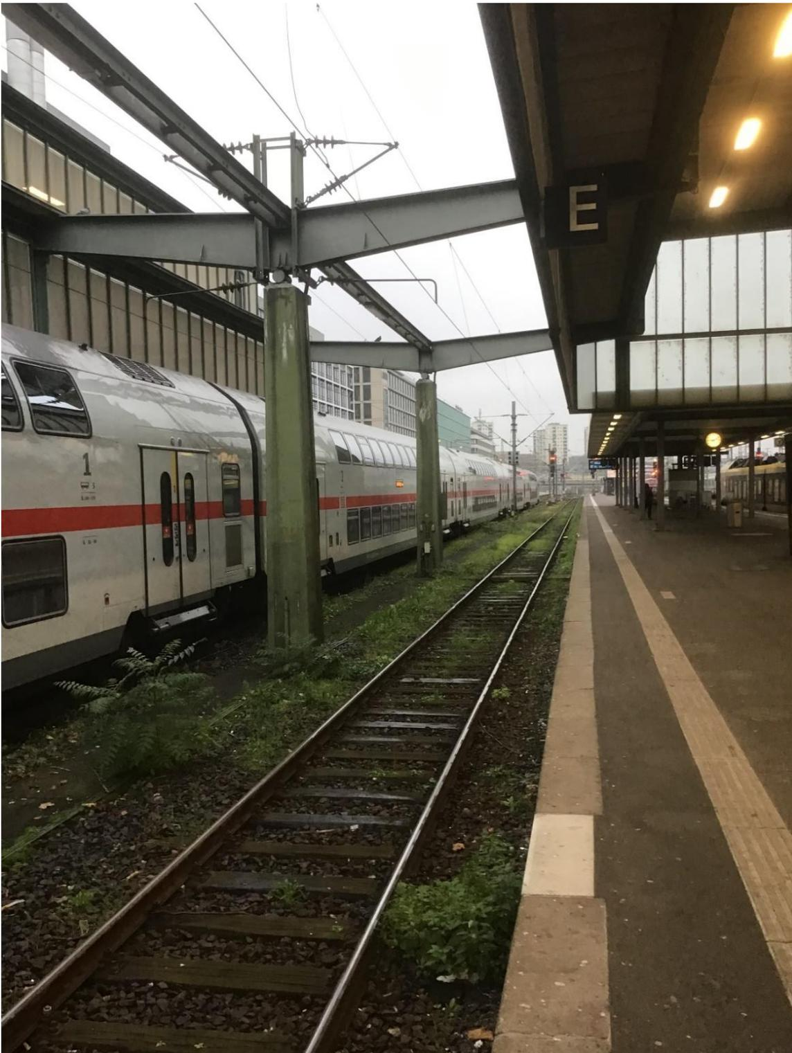
Bild 3: Oberleitung Gleis 2-3 ist an Hallendachträgern angebracht
