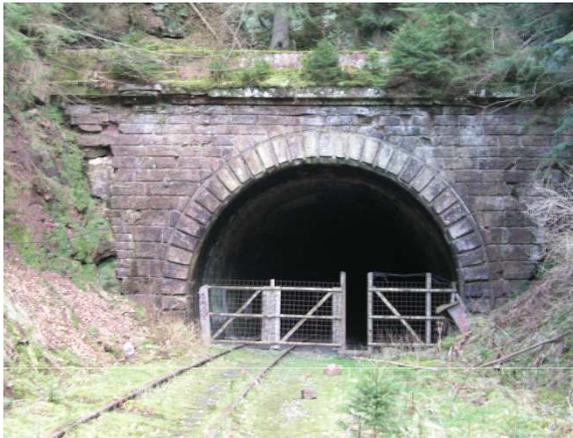
Der elektrische Betrieb erfordert ein größeres Lichtraumprofil, das durch Verlegung des Gleises in die Tunnelmitte erreicht wird. Damit ist der Tunnel dann nur noch eingleisig nutzbar.
