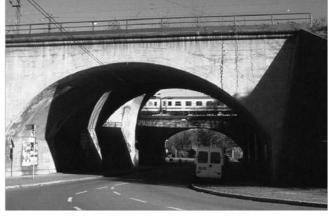
In der Unterführung Ehmannstraße gut sichtbar: Die Gleise verlaufen in zwei Ebenen. Die dritte Ebene (Gleise Richtung Bad Cannstatt) läge parallel zur hier sichtbaren Straße. Damit lassen sich die Fahrwege entwirren und das Gleiswinkel vor den Bahnsteigen vereinfachen.
