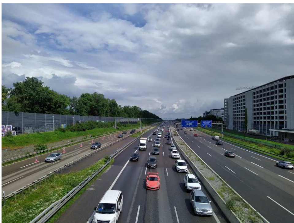
Bild 1: Blick auf die A8 in Richtung Osten von der Brücke zwischen Möhringen und Oberaichen
